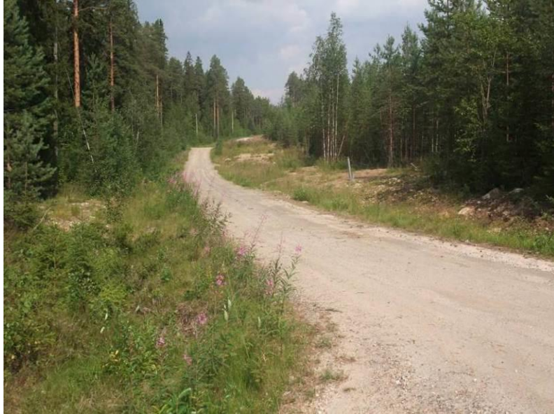
Kuva 20 Sokatie, jonka oikealle puolelle on kaivettu vesi- ja viemärijohto
