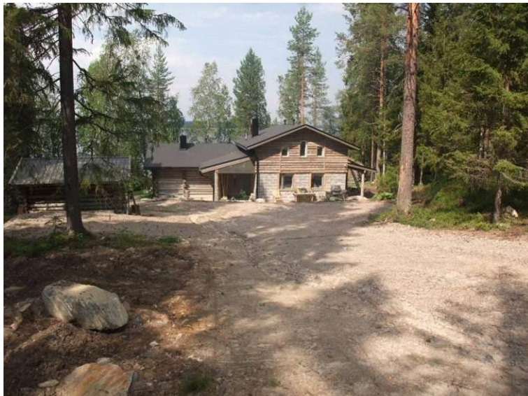
Kuva 9 Tilan 1:200 rakentaminen em. tilan vieressä
