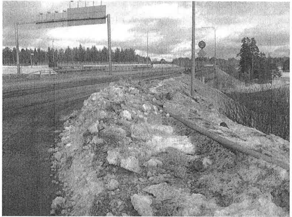
Kuva 25. Nuaskadun kohdalla kiihdytyskaistan rakentaminen valtatielle vaatisi sillan leventämisen.
